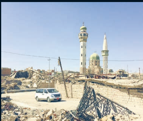
Totale Zerstörung in der Altstadt Mossuls. Krieg.
